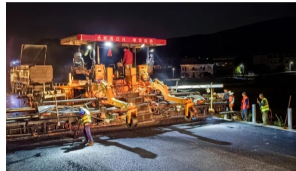
衡永路面1标二分部沥青上面层摊铺完成
